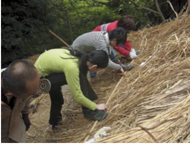
図 20) 茅葺き作業
