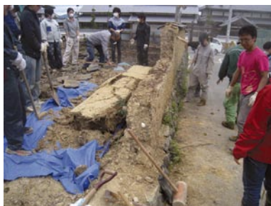
図16) 大藪家土塀の土の救出作業 2010/5/27
