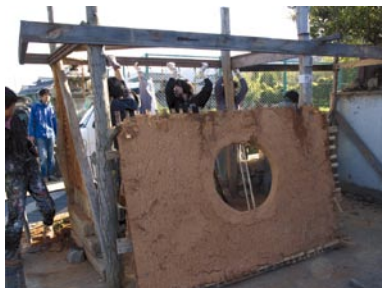
図15)「峠の茶屋」の解体と材料回収
