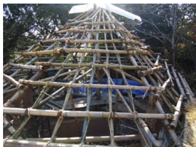
図19) 屋根の小屋組みをつくりなおす
