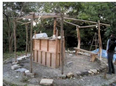
図10) 版築壁と柱の位置決め
