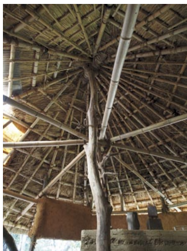
図25) 屋根裏を見上げる 2012年10月現在
