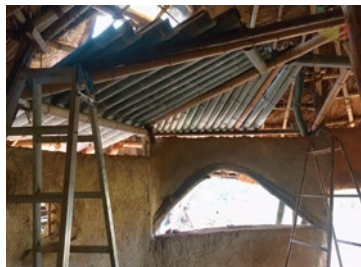
雨漏り対策とロフトを兼ねた内屋根完成 2020/1/23
