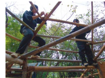
竹で屋根の小屋組をつくる 2010/10/14
