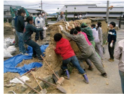
大藪家の土塀を倒して土を救う。土約12トン、土嚢は400袋を越える。2010/5/11~5/29
