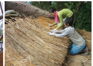
斎藤親方の指導で屋根にカヤを葺く 2012/8/27
