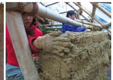
土ブロックを積んで壁をつくる 2011/12/8
