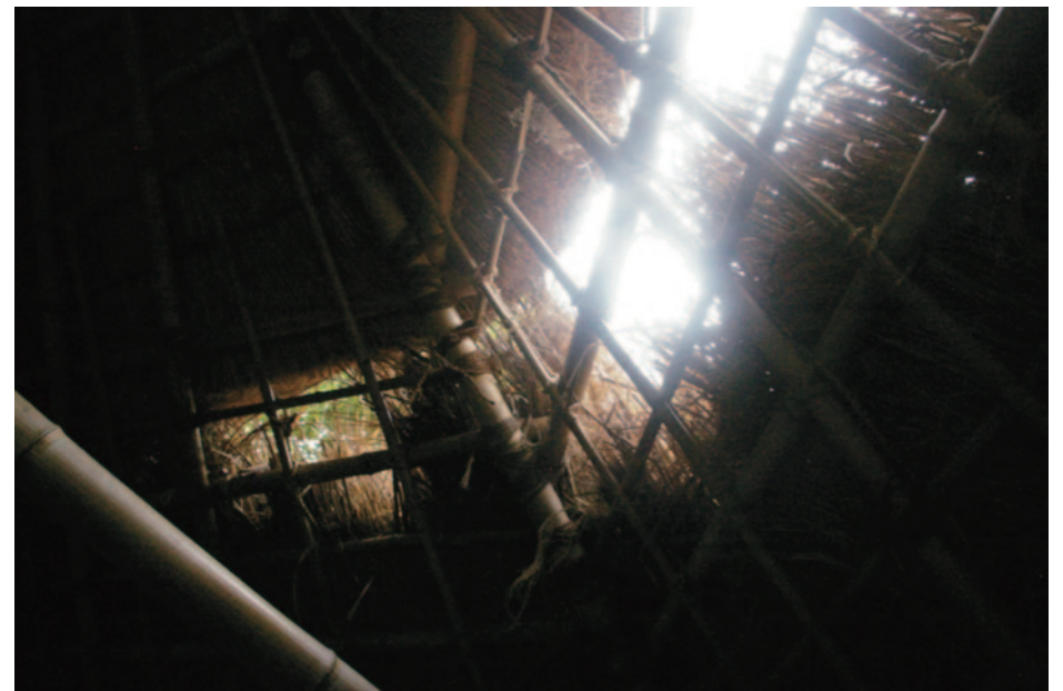
つちのいえの中から撮影した作業中の萱葺き屋根
