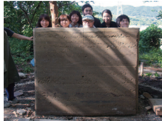
版築型枠外し 2009/9/17
