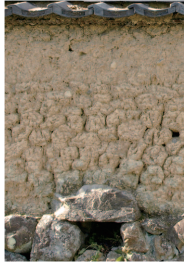
大藪家土塀。漆喰仕上げもなく、練った土団子を積み上げた素朴な風情。阪神大震災にも耐えた。
