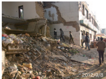
工事の瓦礫で埋まるフフホトの旧市街をフィールドワークする。
