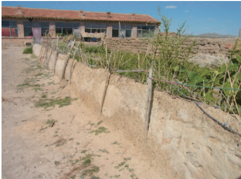
食堂近くの小さな村に足をのびして、土の使い方を調査する。細い茎で粗い小舞のようなものを編んで、草を混ぜた土を塗った仕切り壁。
