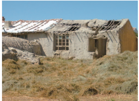
ぶ厚い土壁の建物。人家ではない。乾燥地らしく、屋根も草を混ぜた土を塗っている。屋根が落ちているので構造がよくわかる。
