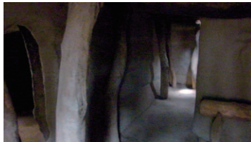
中は薄暗く迷路状。木の柱が梁を支え、壁と柱の二重構造で頑強である。天窓から明かりをとる。
