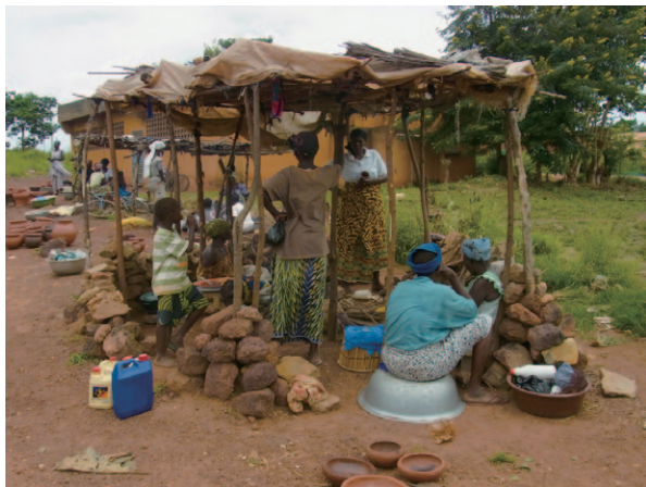
ラテライト石を寄せ集めて柱を立てている。コンクリートブロックがないのはいいことだ。
