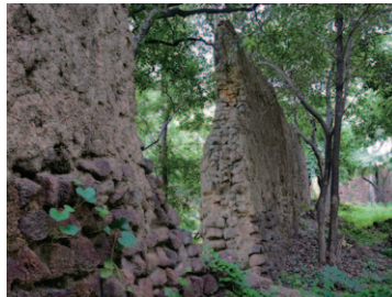
壁の断面。壁の厚みや石積みの仕組みがよくわかる。
