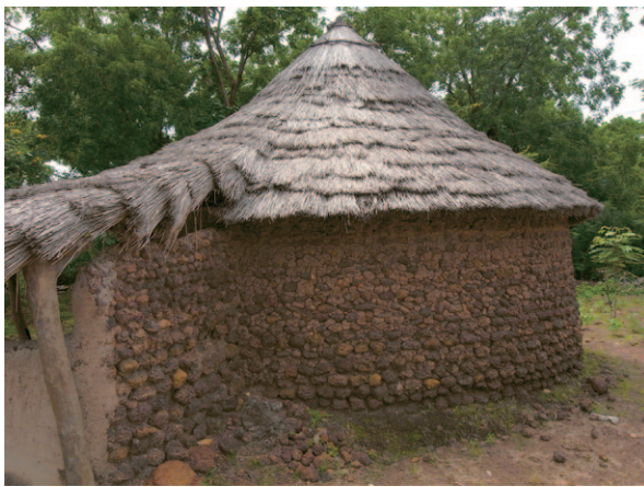
ガンの家とその側面（写真下）。側面はラテライトの石を積み上げ、上塗りはしていない。
