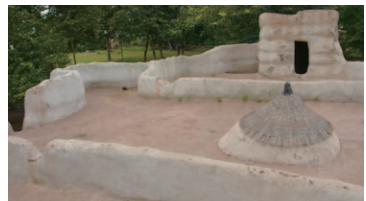
テラスには部屋の壁が突き出ている、部屋の配置がそのまま反映されている。主が使う小部屋が見張り小屋風に突き出している。編笠の下は穀物庫である。
