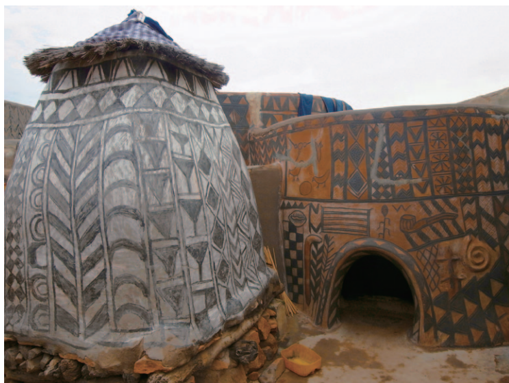
左が第一穀物庫。右は母の家(ディニヤ)。入口は約80cm。風雨と動物対策のため、入ってすぐに低い壁がある。
