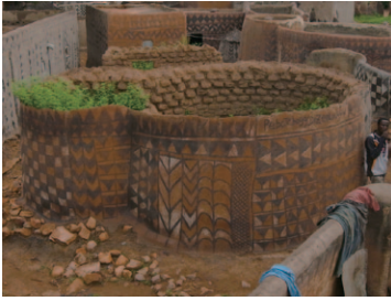
屋根が落ちて、レンガ積みと目地の分厚さがわかる。崩れた家や塀も多い。生成と崩壊が共存している。
