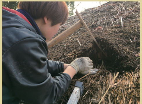
2019年12月29日、山形からやって来て、つちのいえの傷んだ屋根を修復してくれる茅葺き職人・木下愛理。ガンガンなど道具も自前。
