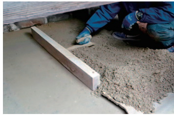
土を入れる。仕切りを使って、前日の三和土部分に混ざらないようにしている。
