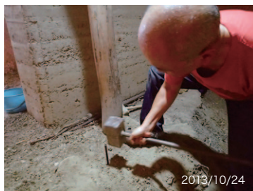
鉄杭を打ちこんで柱の基礎を補強する長谷川先生
