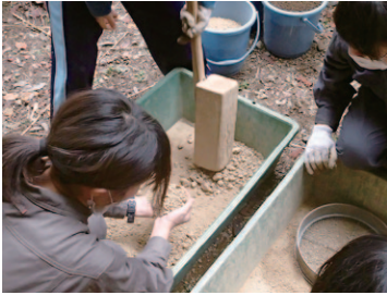
固まった土を砕く。使う土は、アクアカフェで用いた大藪家の土塀の土、それに今回室内の地面を掘って出した土を混ぜる。
