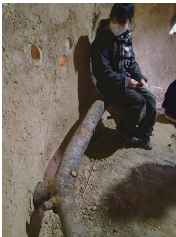
壁の竹筒に桜の枝を差し込み、ベンチを仕立てる。
