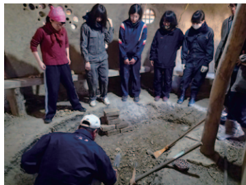
ちょうど土間座制作中で、「たたき鍬」を用いて、たたき方を教えて下さった。側壁のレンガを斜めに組むのも、浅原さんの示唆による。
