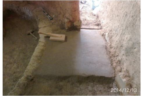
東側の出口部分の三和土。下地に凹凸があるので、厚さが必要になる。
