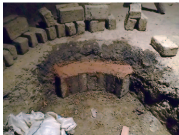
レンガどうしを接着する際は、レンガを水でよく濡らし、土を水でゆるく練って糊状にしたもの(土ポンド)をたっぷり塗る。赤土を使って目地を目立たせる。
