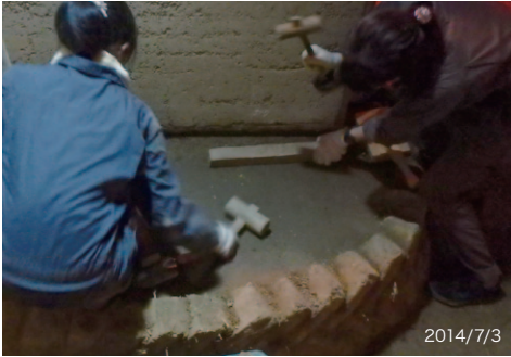
版築壁の前の部分。表面が見違えるようにきれいになっていく。
