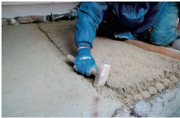
前日たたいた部分の端をげんのうでつぶして、新しくつけ加える部分となじみやすくする。
