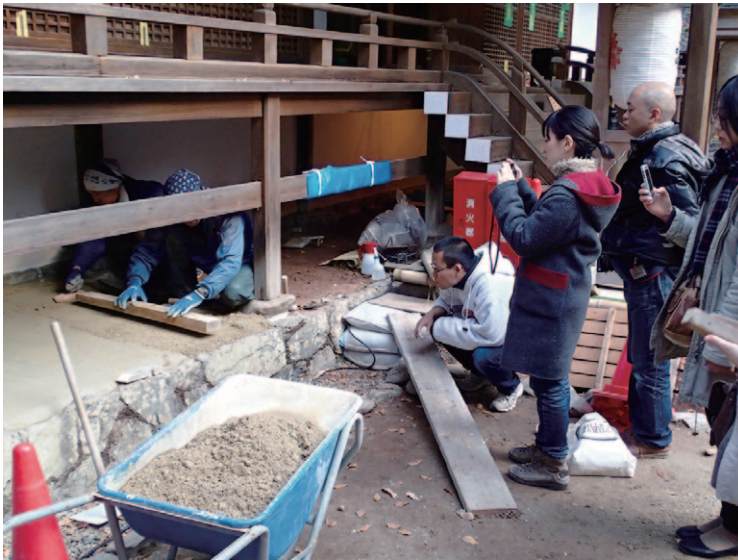
一同、職人さんたちの作業に見入る。一輪車にはふんわりとした土。深草土に生石灰とにがりを混ぜている。
