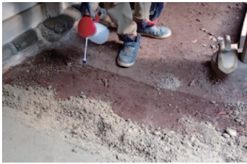
前日に叩いた部分につなぐ部分。土を入れる前に水で湿らせる。
