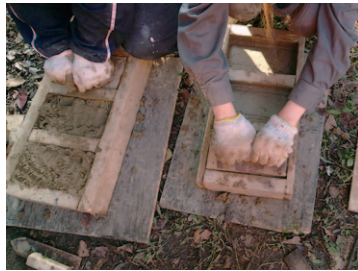
2x4の廃材でつくった型枠にぴったりの押し板をつくって、土をしっかり押し込む。木づちでたたき込んでよい。
