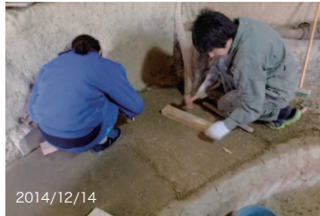
東側の出口部分の三和土。下地に凹凸があるので、厚さが必要になる。
