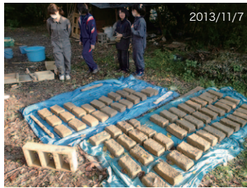
慣れてくるとピッチが上がり、一日で50個できた。だが、側壁を全部レンガで固めるには、この倍以上が必要。
