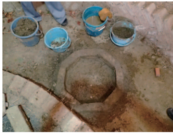
泥でつなぎ固めていく。
