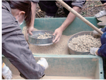
土をフルイにかける。土塗りの場合は念入りに粒をそるえるが、レンガづくりの場合は多少小石が混ざっていてもかまわない。
