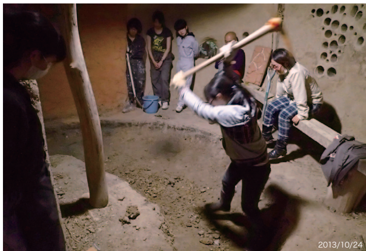
陶磁器専攻の学生(高江洲佳乃)はツルハシの使い方もうまい。掘って出た土は日干しレンガに再利用する。
