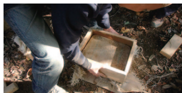
ひたすら日干レンガづくり。布を用いて土ブロックを型枠から外しやすくし、効率アップ。
