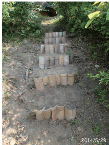
急な北側斜面に割竹で階段をつくる。
