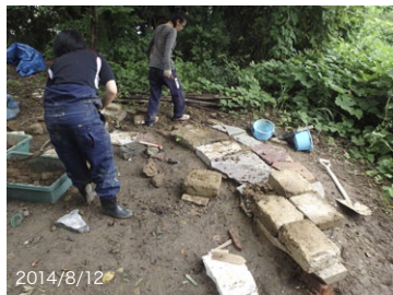
土ベンチの位置に、水と縁切りのため石を敷き並べる。
