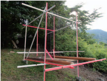
片持ち梁でテラスを1m斜面上に突き出すことを決定。
