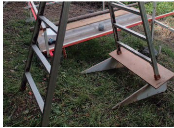
斜面なので脚立が立てにくい。応急処置として、廃材で「斜面矯正台」をつくる。足場をつくらずに済んだ。
