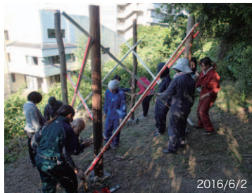
梁や桁の位置を決めるため、柱を相互に直立させる。
