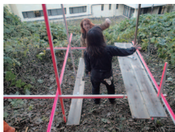
角材による実寸大スタディで位置や方向を検討。(角材は井上明彦の元崇仁小学校での作品展の廃材。)
