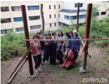
4本の柱を礎石に乗せ、石場建て構法の出発式。
