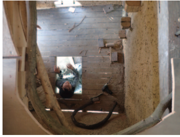
床の上がり口を見下ろす。
