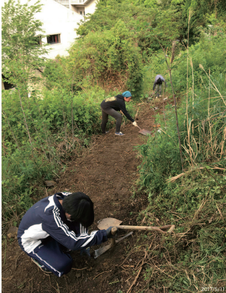
2017年5月11日、土浮庵再建と同時に作業開始。
