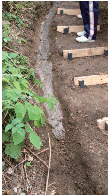
改良後の階段。溝も掘り、杭をしっかり打って蹴込み板を固定した。
