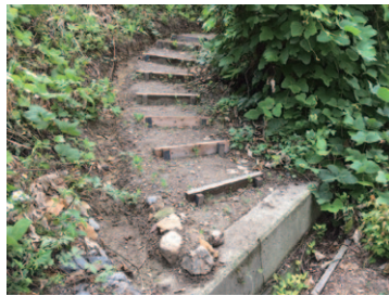
改良後の階段。溝も掘り、杭をしっかり打って蹴込み板を固定した。
