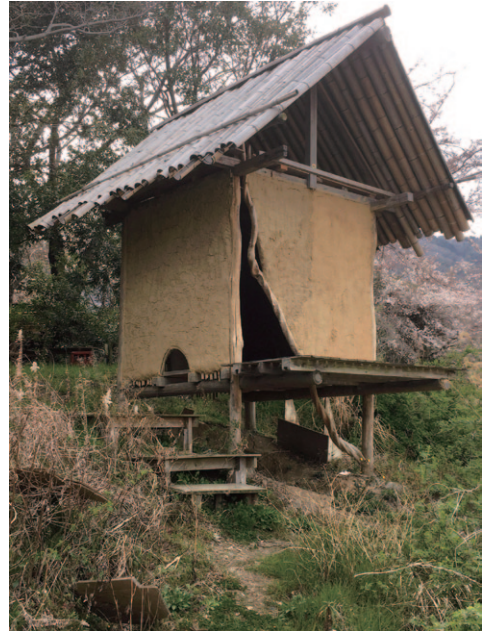
道の終点・土浮庵の横の階段は、最終的に3段になった。
