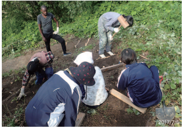
大きくカーブする部分の階段づくり。掛軸で杭を打ち込む。
