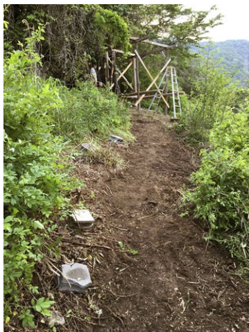
土浮庵再建現場から右斜めに降りる道を開く。
