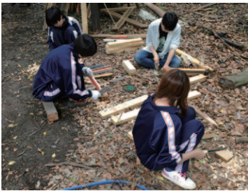
階段をしっかり作るため、杭と蹴込み板をつくる。
