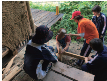
大きくカーブする部分の階段づくり。掛軸で杭を打ち込む。
