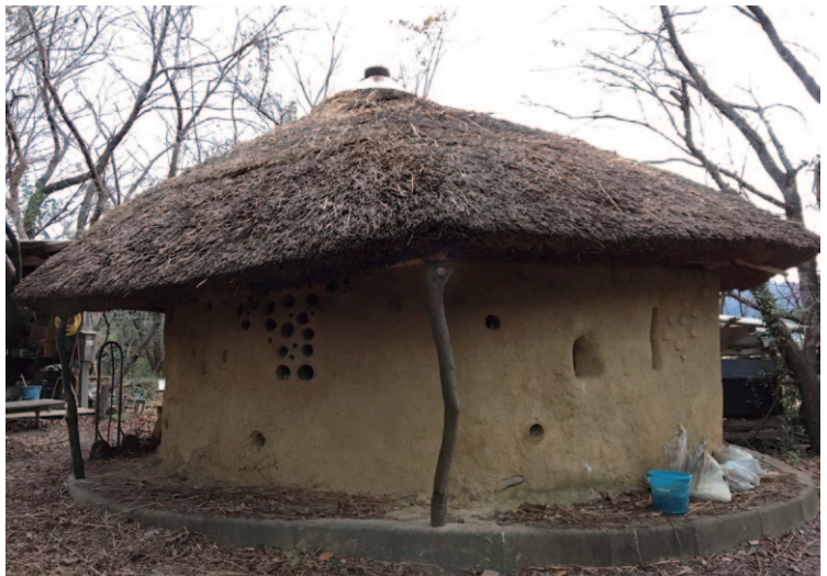
丸太を突っ込んだ竹の梁を、丘の生木の柱で支える。
