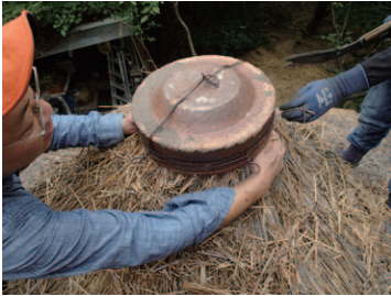
刈り込んだ天辺に陶器のサヤをかぶせて応急処置。
