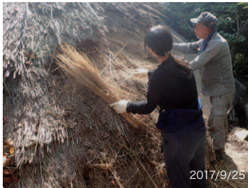
足場を建てて、古いワラをめくる
