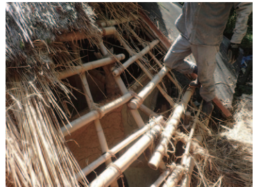
めくって現われた竹屋根の骨組み
