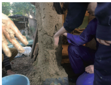
土をしっかりと塗りこめ、柱と壁の修復を行う。
