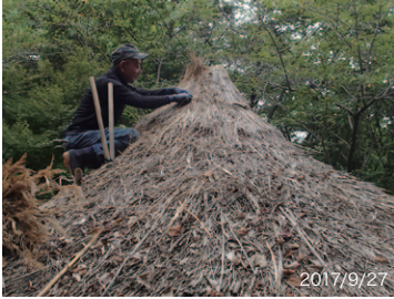
高く尖らせていた茅屋根の折れた天辺を直す
