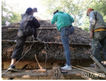
足場を吊って作業する。
