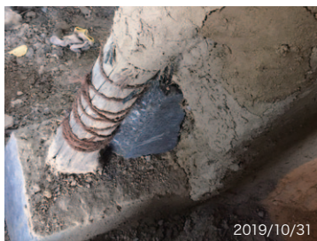
土塗りの前に柱にシュロ縄を巻き、隙間に石をつめる。
