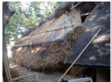
茅束は端では斜めにしてケラバ(断面)を見せる。
