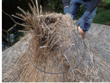
大黒柱が見えていて、雨が伝うので針金で巻き縛る。
