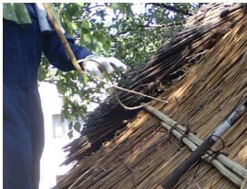
編み込みの作業。針状に穴を空けた細竹に縄を通し、屋根に突き刺して、押え竹に縛りつけていく。(※p.74)
