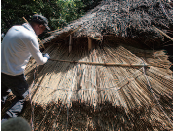
挿シ茅で傷んだ部分を補修して下さる吉田親方。
