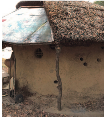
丸太を突っ込んだ竹の梁を、丘の生木の柱で支える。
