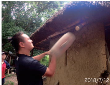
丸太を竹の梁に打ち込む。
