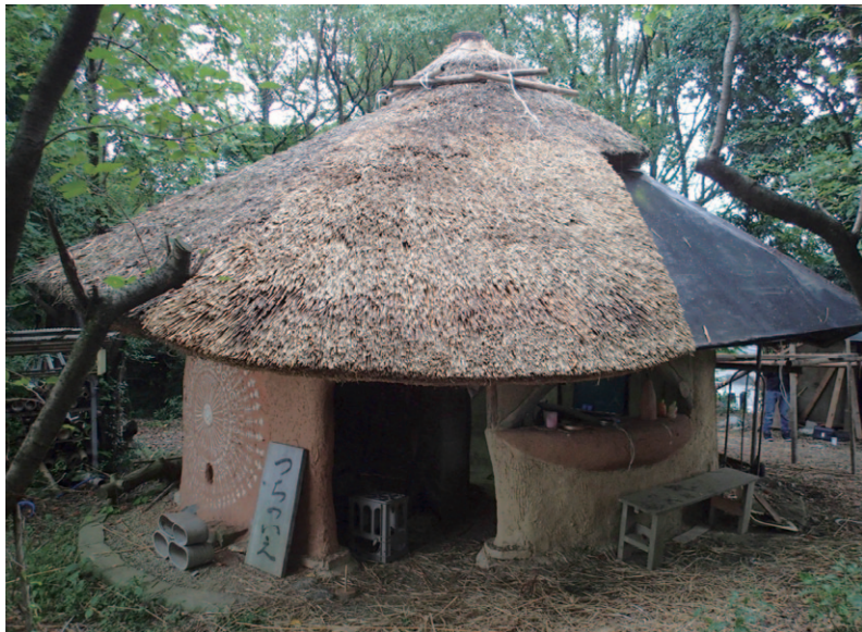
刈り込んだ天辺に陶器のサヤをかぶせて応急処置。
