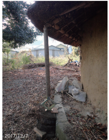
丸太をジャッキアップして梁を支え、まっすぐに直す。
