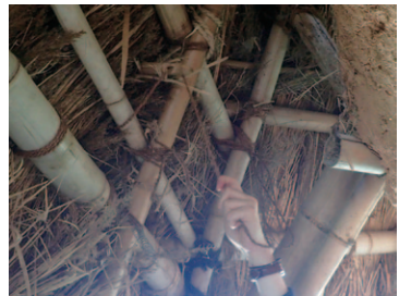
編み込みの作業。針状に穴を空けた細竹に縄を通し、屋根に突き刺して、押え竹に縛りつけていく。(※p.74)
