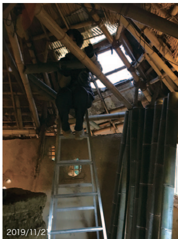
既存の竹梁の間に、屋根竹を受ける竹を取り付ける。
