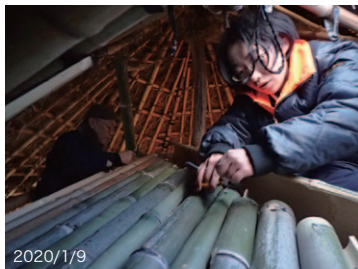
年明けの1月9日の作業。上端を針金でとめていく。
