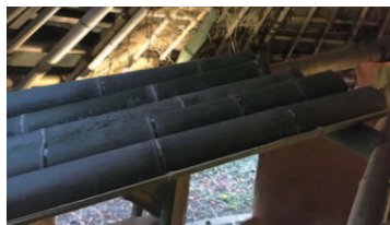
半割りにした竹を上下合わせて載せてみる。
