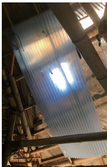
穴の下にポリカ波板を入れて雨水を外に逃がす処置。
