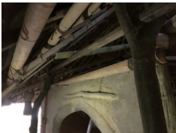
梁はぴったり水平になった。竹を渡して角度をチェック。
