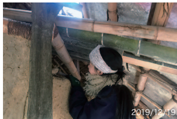
竹材の軒からの出具合を確認する。
