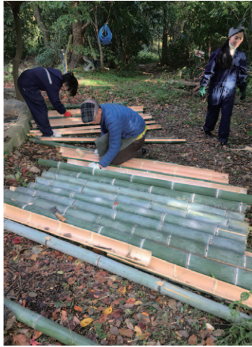
半割りにした竹を並べ重ねて量のシミュレーション
