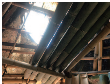
竹材は梁と方向をそろえて仮留めしていく。
