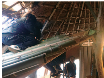
竹屋根に乗りながら竹材を固定する作業を続ける。
