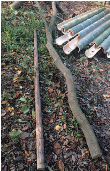
切った枝の長さ=柱の高さ。左はメジャー代りの丸太。
