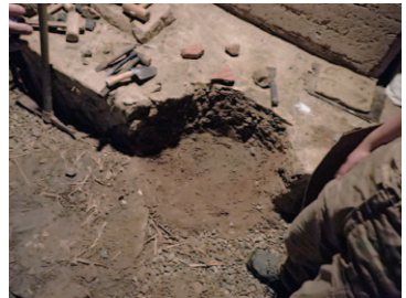
つちのいえでは、壊すことと創ることはたえず循環する。崩した土は集めて再び日干しレンガにする。
