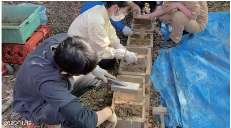
崩した土間座の土に赤土をまぜ、木枠に入れて日干しレンガを再生する。(cf. p.133)
