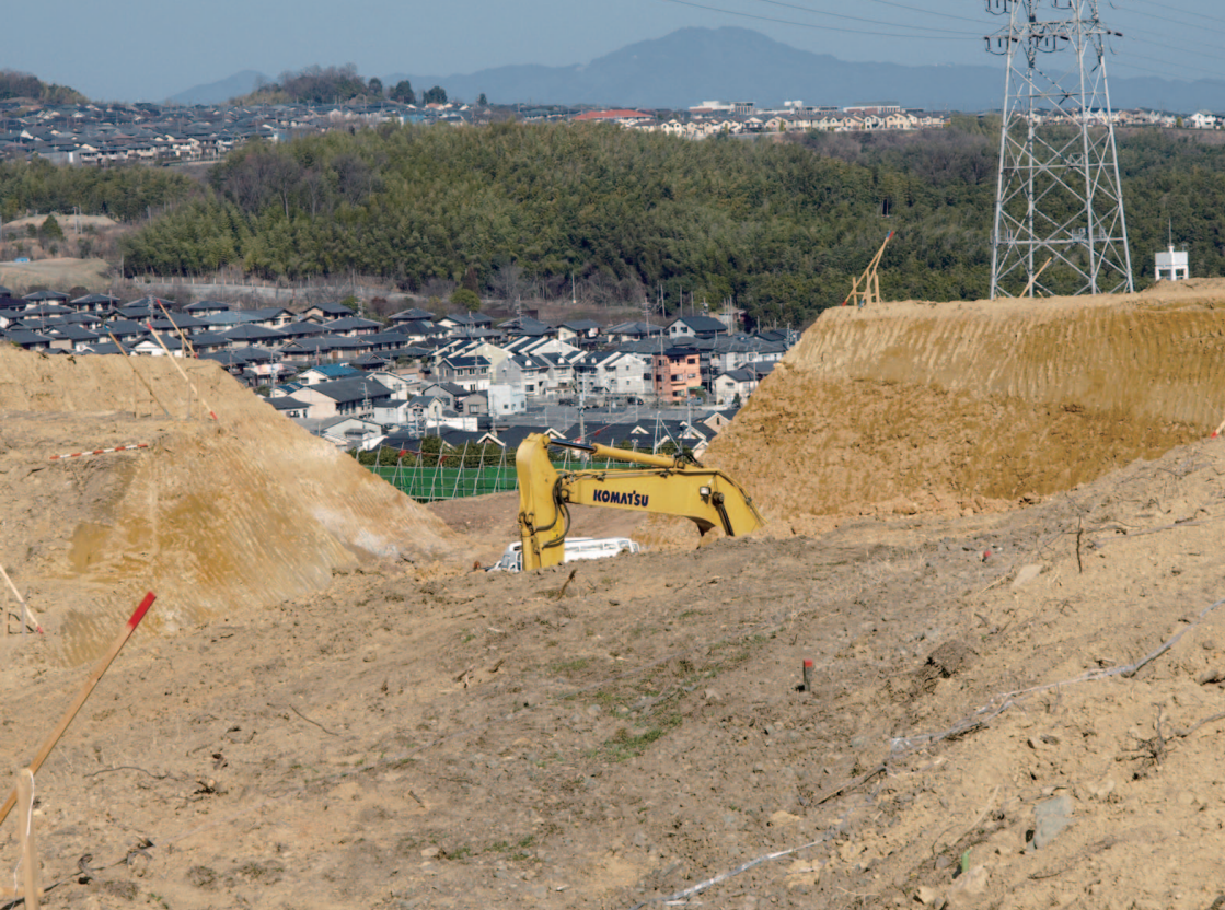
京都芸大西側での沓掛インターチェンジ建設のための土木工事から（2010年2月24日）
