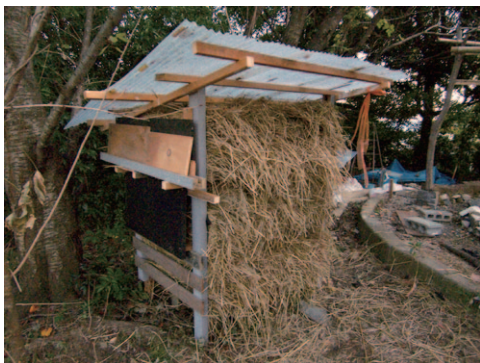
集めた藁を納める小屋を廃材でつくる
