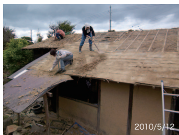
屋根から土を落としていく。
