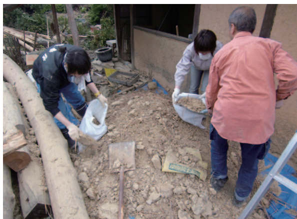
屋根土と壁土を土嚢につめていく。土嚢は全部で150袋前後になり、門屋だけで土を3トン近く集めたことになる。土嚢はつちのいえの丘に何往復もピストンで運んだ。
