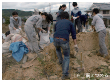
土を土嚢につめる
