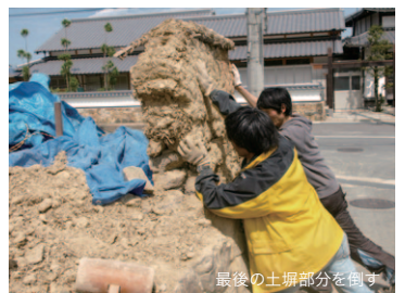
最後の土塀部分を倒す
