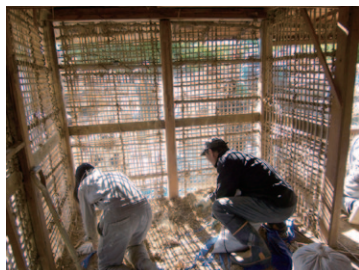
魚の骨から肉をほじるように、壁土を丁寧に掻き集める。土は極上。昔の左官職人の手を感じる。
