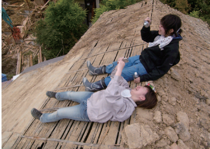
二百年以上昔の屋根には瓦を留める大量の土とスサがのっていった。古い野地板は竹製だった。「芸大に入ってこんなことをするとは思わなかった」(木下愛理・稲垣若菜)
