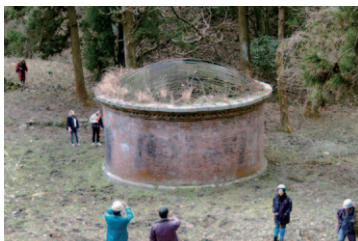
第一竖坑。大津と山科を結ぶ小関越え沿いにあるが、一般公開されていない。琵琶湖疏水第1トンネルのフィールドワークにて (2010/2/19)
