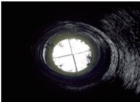
琵琶湖疏水第1トンネル内より、第一竖坑を見上げる。Rをつけた煉瓦の手積みが見え、ゆらぎのある曲面を形づくっている。撮影 2010/2/19
