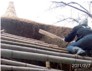
タタキでケラバ(茅葺きの端の部分)の面を整える。
