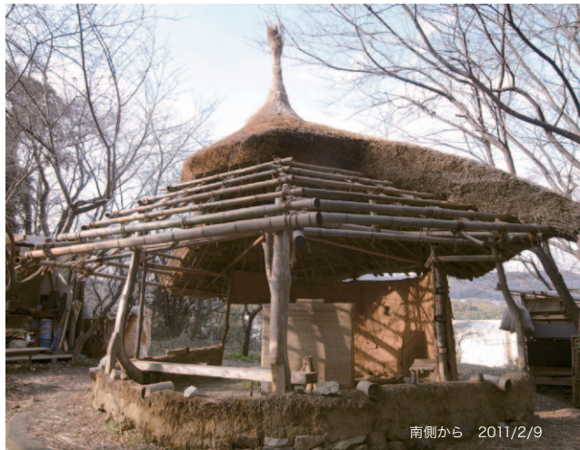
トンガリ屋根の仕上げ。穂先のついた長いヨシと、短めの茅を交互につけ回す。根元は茅束を編み回して太くする。編みつけは太さ1mm弱の銅線(一部、針金)。シュロ縄はあくまで飾り。
