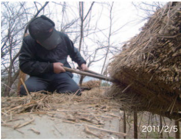
軒の刈り込みをする斎藤親方。翌日入院するにもかかわらず、屋根仕事のネリをつけるために来て下さった。
