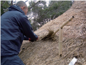
親方が滋賀の野洲から助っ人に呼んだ茅葺き職人の吉田顕さん(畑中屋根工事)。はみ出ている縫い竹を切り、茅を持ち上げて新しい茅を差し込むサシガヤ。
