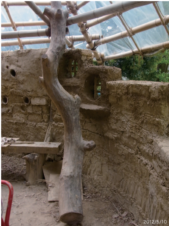
壁は厚いので、窓枠を二重にする。枠に巻き付けた縄に土をしっかりと塗り込む。
