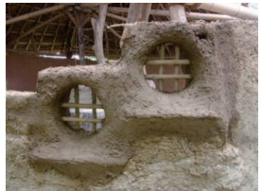
2本つづれて直交する棧のある2つの窓は、梯子の傾きに応じている。
