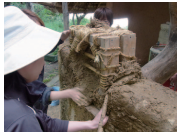
壁は厚いので、窓枠を二重にする。枠に巻き付けた縄に土をしっかりと塗り込む。
