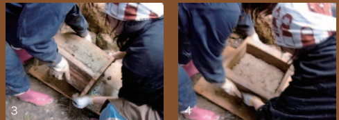
型枠に入れてしっかり踏み固める。型枠の左右に出っ張りをつけ、自重を利用してトントンと軽い打撃を与えると、土が型枠から抜けやすい。
