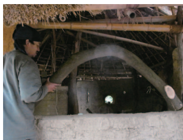
窓にあてがいがながら、取り付け方を検討する。
