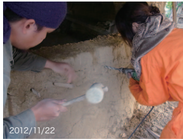
窓の下にカウンターをつけることになり、壁に穴をあけて竹を打ちこむ。日干しレンガは予想以上に固い。
