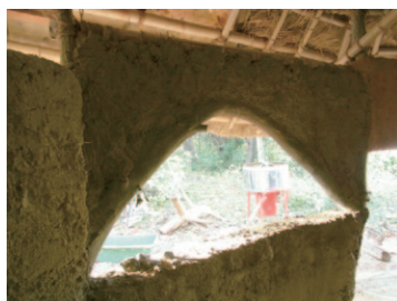
内側からも土を塗る。ここは二重竹木舞ではなく、通常の竹小舞だが、太い枝のアーチのせいで不厚く感じる。
