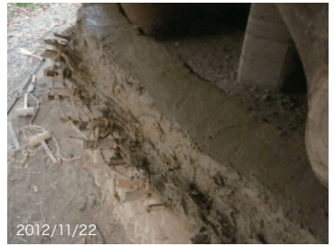
打ちこんだ竹にシュロ縄を巻き、土を絡ませて塗り込む。
