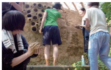
泥ふみと壁塗り：前日に柔らかくしておいた土をブルーシートの上に広げて裸足でこねる。そして素手で手の跡を残しながら壁に塗りつける。
