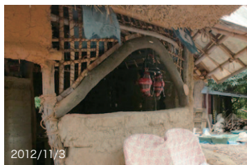
竹小舞と補強材を取り付けた状態で芸祭で公開。
