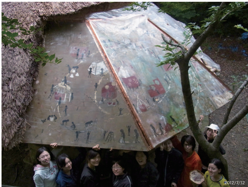
茅葺きの継ぎ目部分を下から押し上げ、布屋根を差し込んで竹の小屋組みに固定する。ハイブリッドな屋根の奇観に近づく。
