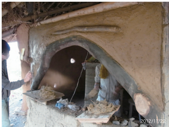
補強材をあえて見えるようにして土を塗る。ほかの壁とちがって、できるだけまるやかな表情になるよう、大藪家の良質の壁土を練ってコテで上塗りする。
