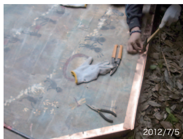
蠟引きの終わった布屋根の上端と左右の端に、水切りのための銅板(建材用、購入)の縁を丁寧に付ける。
