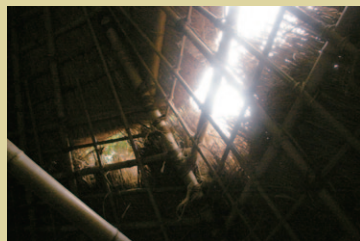
つちのいえの中から撮影した作業中の萱葺き屋根
