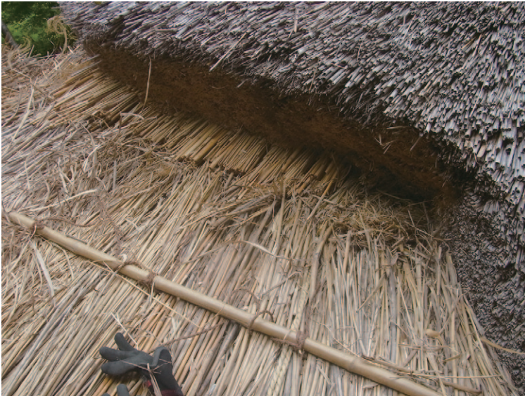
布屋根とのつなぎ部分は、茅束の向きを変えて断面(ケラバ)をこちらに向けるなど、高度な職人技術を要するので、吉田顕師匠が一人コツコツ作業する。
