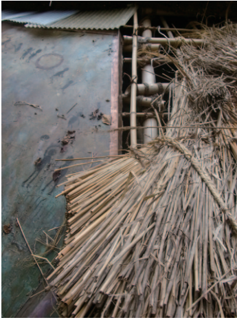
布屋根とのつなぎ部分は、茅束の向きを変えて断面(ケラバ)をこちらに向けるなど、高度な職人技術を要するので、吉田顕師匠が一人コツコツ作業する。
