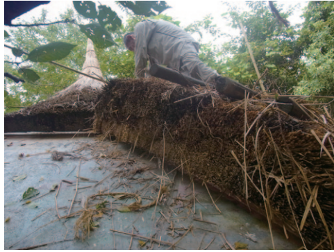
布屋根とのつなぎ部分は、茅束の向きを変えて断面(ケラバ)をこちらに向けるなど、高度な職人技術を要するので、吉田顕師匠が一人コツコツ作業する。
