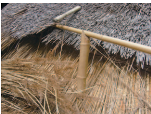
茅の下に竹を差し込んで持ち上げ、新しい茅を下から差し込む「差し茅」。
