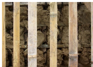
外側から見た塗り土の状態。
